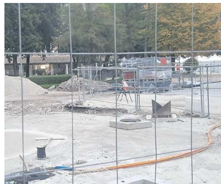
Lavori in piazza Quaranta Martiri a Gubbio
