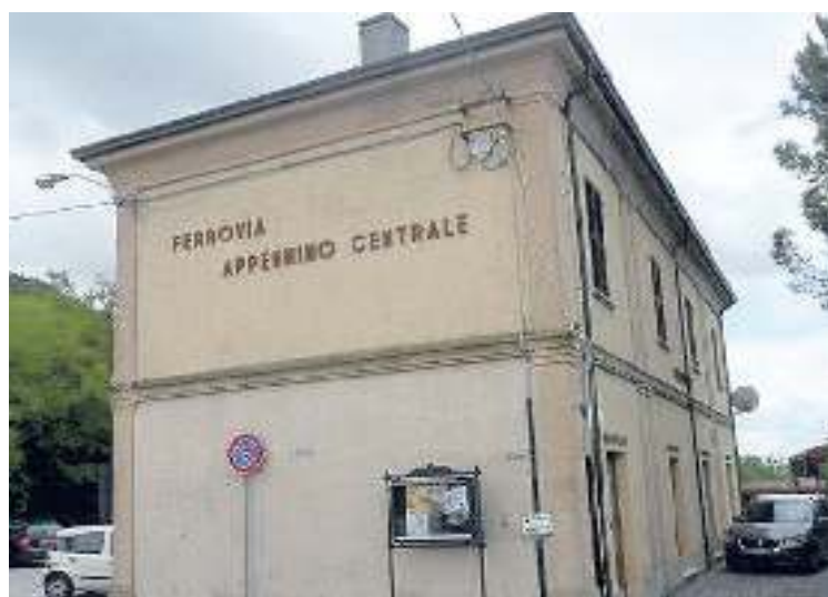
La stazione ferroviaria di Fossato di Vico
